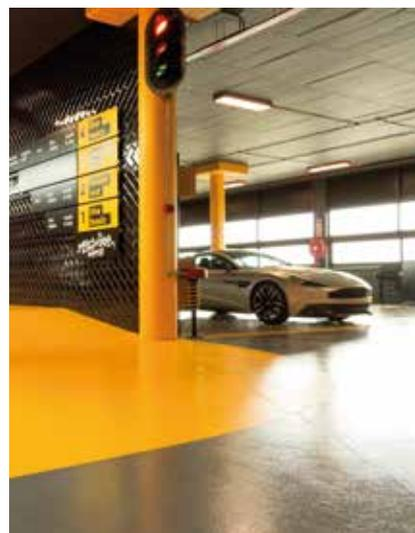
Les résines époxy s'appliquent généralement en intérieur, car elles sont moins souples que les PU et MMA, donc moins appropriées pour accepter des mouvements de supports. Leur tenue aux UV n'est pas non plus un point fort, ce qui en limite l'usage en extérieur.
