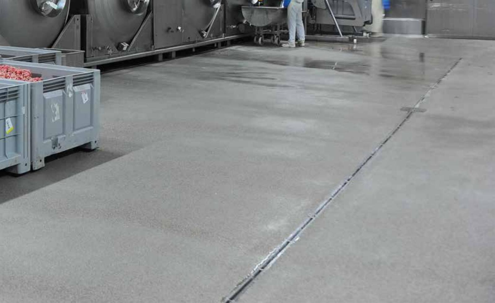
plusieurs décennies d'exploitation. Par exemple : le Pavillon de la viande au MIN de Rungis, 18 000m<sup>2</sup> réalisés en 2000. Ce mortier de résine présente un très bel aspect au bout de 20 ans d'utilisation intensive.
