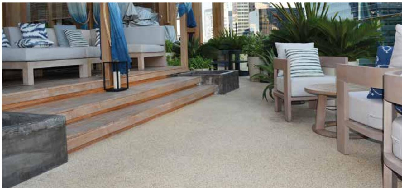
Elle s'applique aussi bien en travaux neufs qu'en rénovation. La moquette de pierre est appliquée généralement sur support stable et dur de type dalle béton ou chape, ou moyennant une appréciation et une préparation spécifique du support existant, sur ancien carrelage s'il est bien adhérent, ou sur dallage/pavage posé sur support béton.
