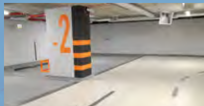
Niveau de fondation
