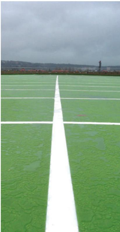
La Gamme FLOWFAST de Flowcrete est constituée de systèmes de résines de sols à base de PUMA (Polyuréthane métacrylate) et MMA (Métacrylate de méthyle). Ces technologies, les plus récentes dans les applications de sol, sont en pleine expansion, car elles apportent des solutions à des situations de contraintes extrêmes, en intérieur comme en extérieur, et sont utilisables dans de très nombreux cas de figures :
