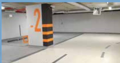
Niveau de fondation
