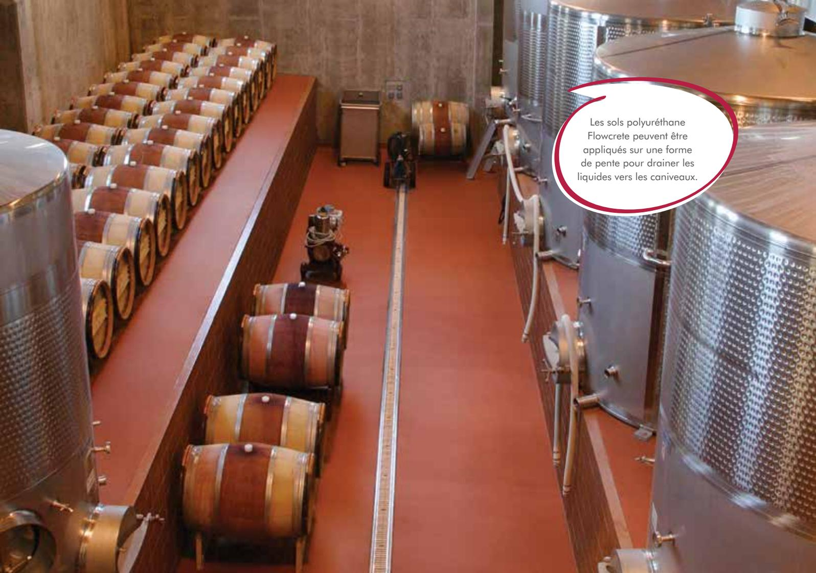
Les sols polyuréthane Flowcrete peuvent être appliqués sur une forme de pente pour drainer les liquides vers les caniveaux.
