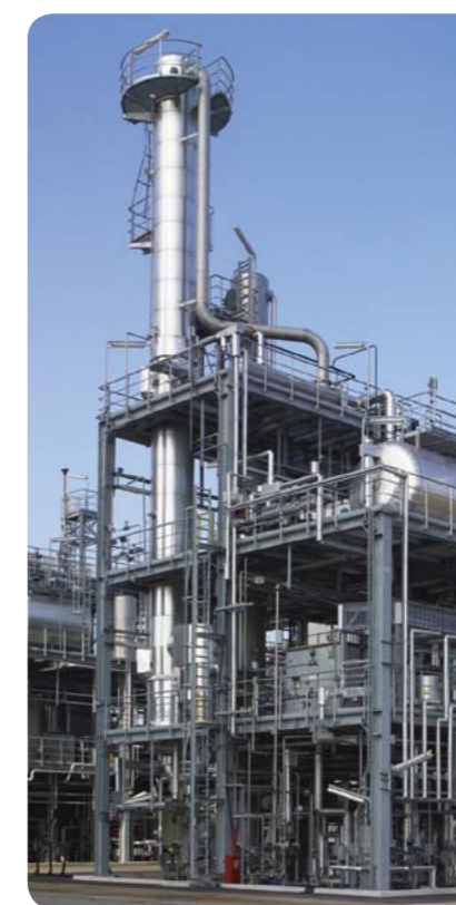
Ochrana ocelových konstrukcí
