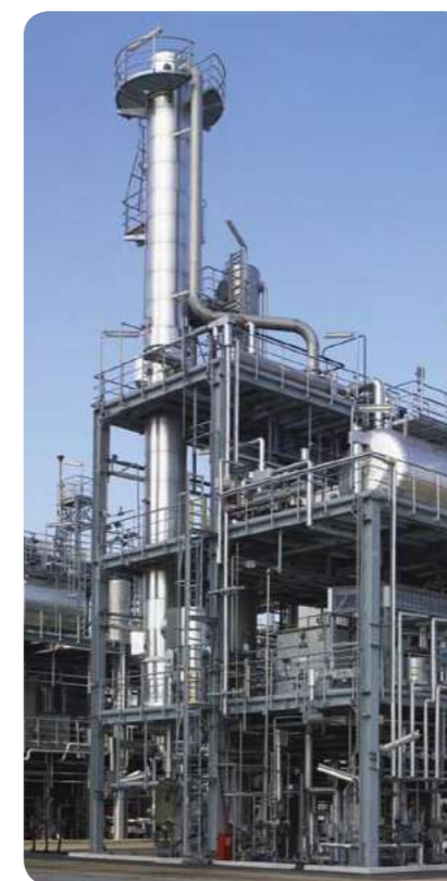
Ochrana oceľových konštrukcií
