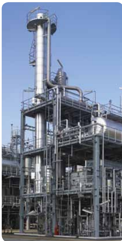
Ochrana oceľových konštrukcií
